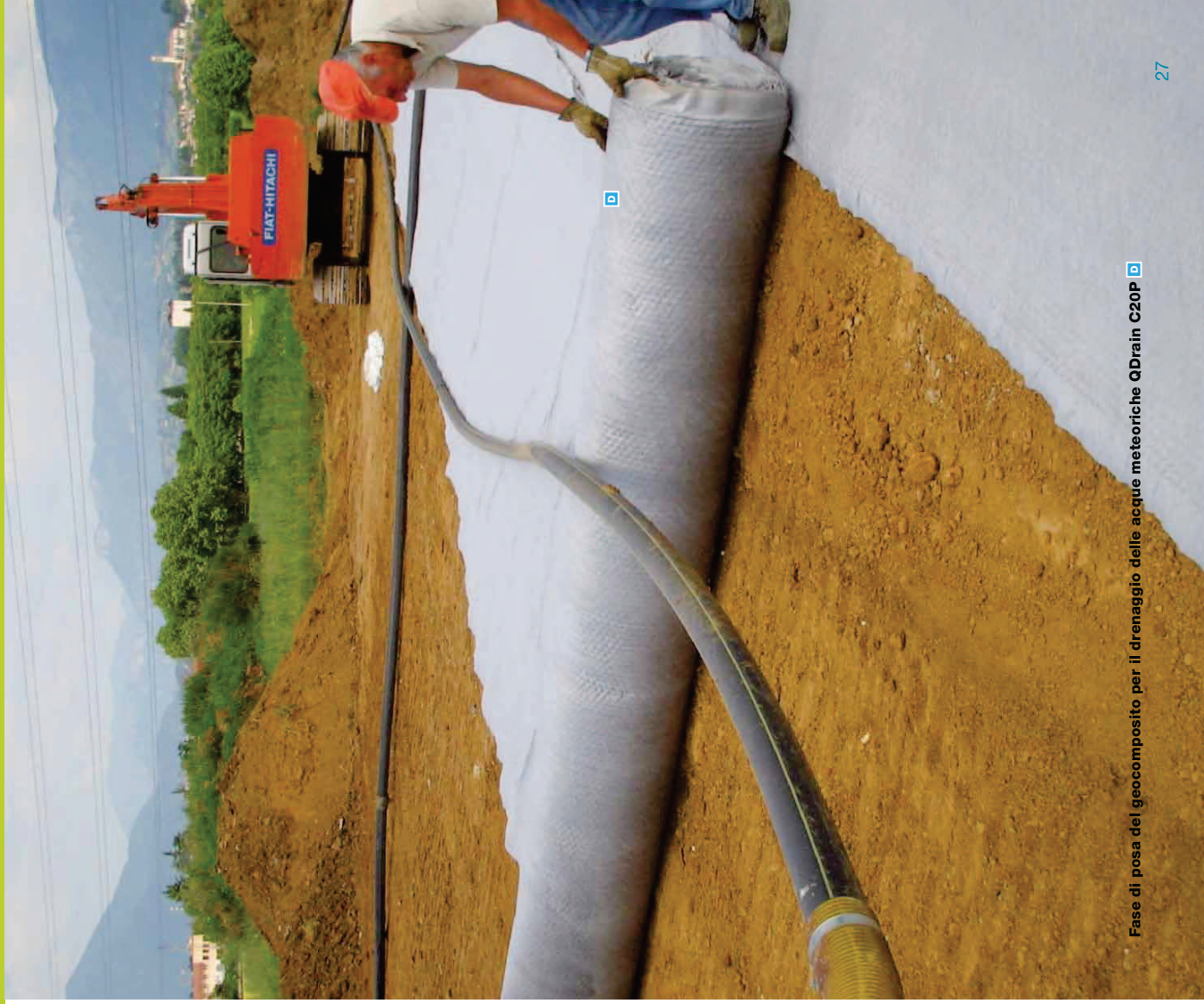
Fase di installazione del geocomposito drenante per il drenaggio delle acque meteoriche QDrain C20 P. Il prodotto sarà interrato sotto 1 m di terreno vegetale
