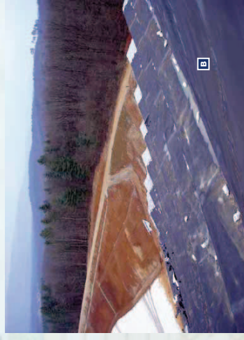
Capping di discarica secondo il metodo Tema: geomembrana con funzione barriera in HDPE B
