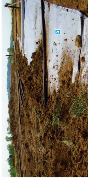
Fase di installazione del geocomposito drenante per il drenaggio delle acque meteoriche QDrain C20 P. Il prodotto sarà interrato sotto 1 m di terreno vegetale
