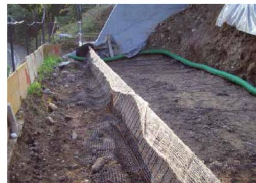
Particolare del drenaggio a tergo dell'opera all'inizio dell'installazione del sistema terra rinforzata. Il collettore drenante viene posto alla base del locale interrato.
