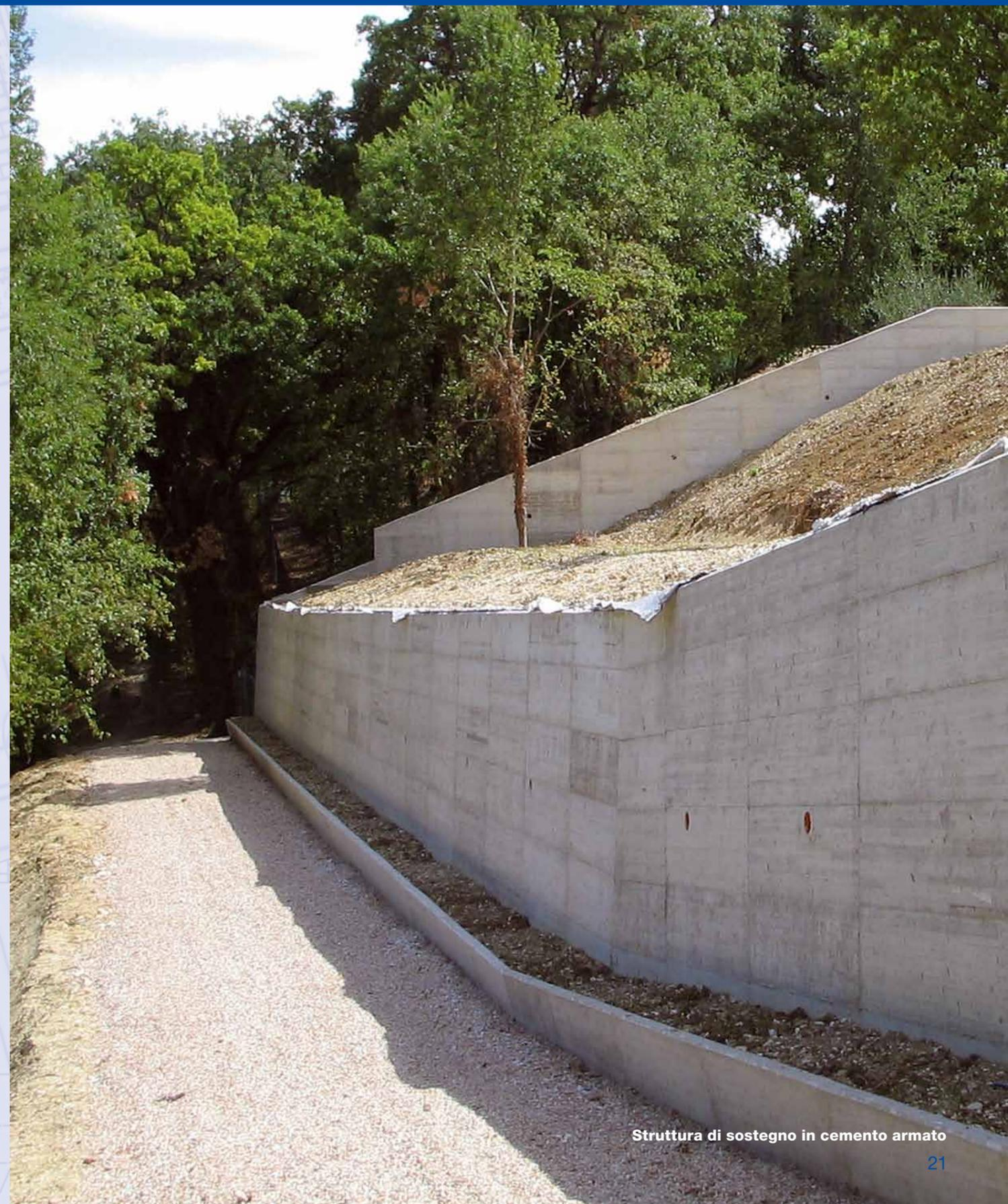
Struttura di sostegno in cemento armato
