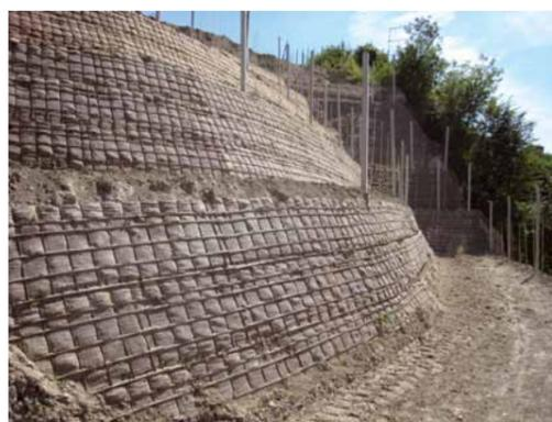
Particolare dell'opera terminata, da cui è evidente l'utilizzo tra elemento rigido metallico e geogriglia di rinforzo dell'elemento per il controllo dell'erosione Ecovernet J 500 (in fibra di juta al 100%).
