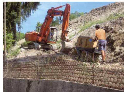
Per la fase della compattazione del terreno di riempimento viene abitualmente impiegato un minicompattatore al fronte per non danneggiare la casseratura metallica.
