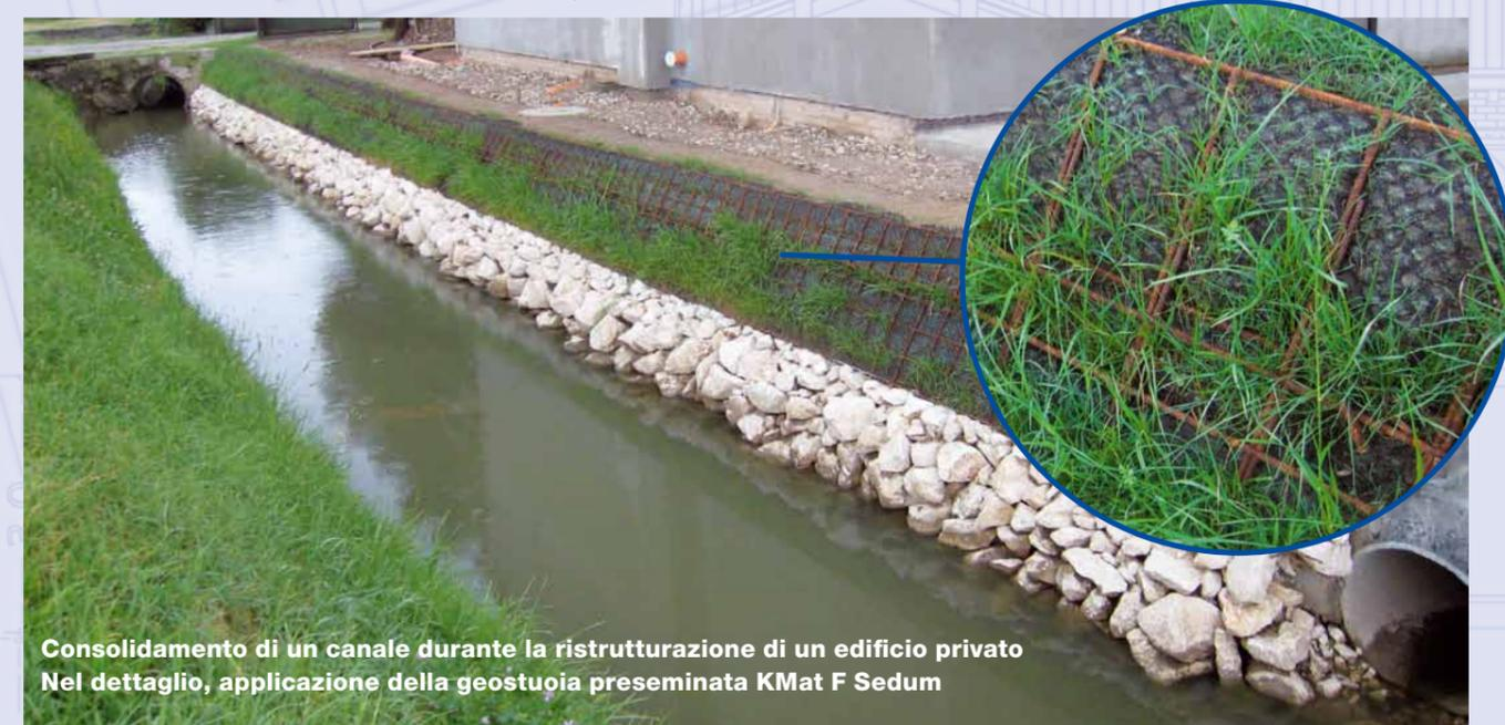
Consolidamento di un canale durante la ristrutturazione di un edificio privato. Nel dettaglio, applicazione della geostuoia preseminata KMat F Sedum
