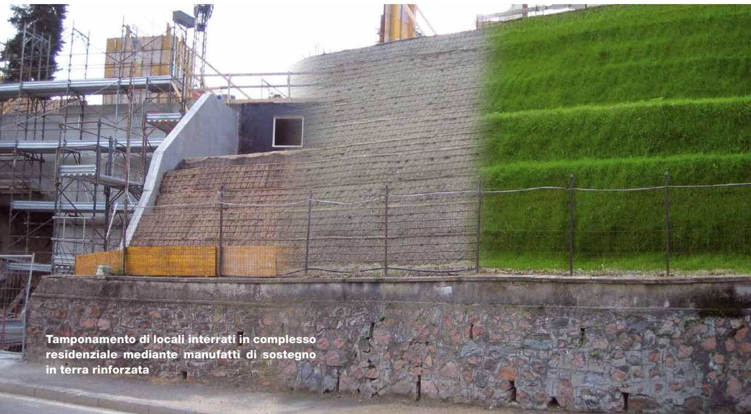
Tamponamento di locali interrati in complesso residenziale mediante manufatti di sostegno in terra rinforzata
